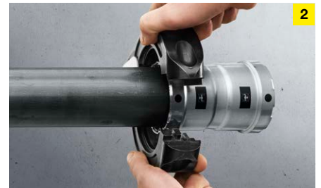
Om Megapress-fittingen vanaf 1\frac{1}{4} duim te persen worden uitsluitend persringen met scharniertrekklaauw gebruikt. In kleinere maten tussen \frac{3}{8} en 1 duim kunt u kiezen uit zowel persbekken als persringen met scharniertrekklaauw.
