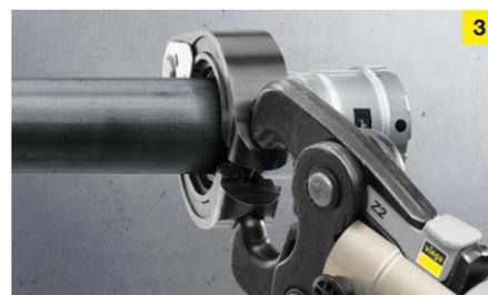
3 Le raccord est sertir et relié au tube par adhérence en quelques secondes à l'aide de la machine à sertir Viega.
