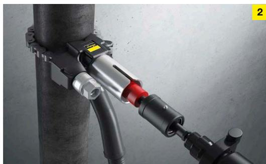
2. Réaliser le perçage à l'aide de la perceuse et retirer à nouveau le dispositif d'alésage.
