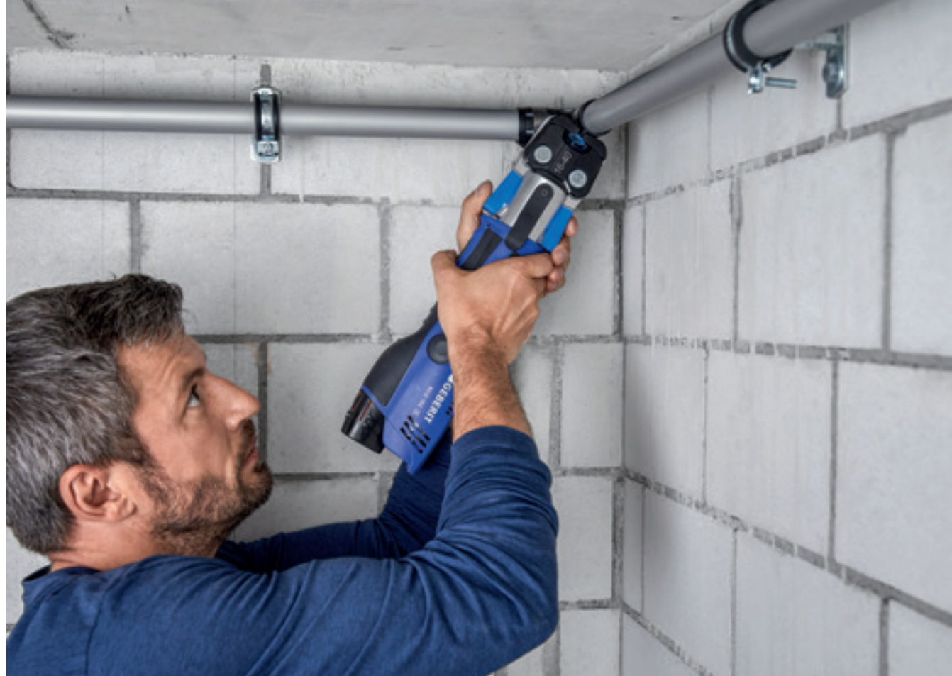
↑ Un montage en toute sécurité est garanti, même dans les endroits très étroits et difficiles d'accès. La position de travail confortable, rendue possible par le raccord rotatif, ainsi que l'absence de collerettes de sertissage facilitent les installations en hauteur, y compris dans de grandes dimensions.
