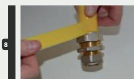
Assurez-vous que tous les joints sont mécaniquement sains avant de procéder à un test de chute de pression. Une fois sûr que l'installation est étanche au gaz, envelopper tous les PLT et écrous exposés avec du ruban auto-vulcanisant. Ceci doit prévenir les risques de corrosion qui pourraient résulter de l'infiltration de débris corrosifs ou de produits de nettoyage.
