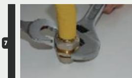
Serrez le raccord à la main, puis rendez-le étanche en utilisant deux clés (une pour tenir l'hexagone sur le raccord, l'autre pour serrer l'écrou) afin de réaliser un raccordement absolument étanche aux gaz.
