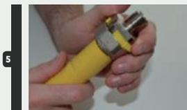
Poussez le GFS® PLT fermement dans le raccord GFS® en veillant à ce que le tube soit complètement inséré et à ce qu'il touche la butée du corps du raccord.
